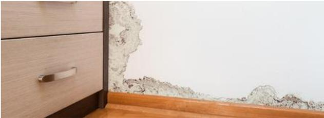
とにかく現場を見ることが大事なので訪問してみると、確かに室内はカビの匂いがしています。下駄箱と廊下に近い和室の押入れの中と壁紙にもカビが発生しています。靴や洋服に白いカビが点々と付いていて、クリーニングしても着るのは嫌だろうなと思いました。築古マンションのカビ発生は給排水からの漏水や雨漏りが原因であることが多いのですが、この部屋は給排水管のない場所や外壁に面していない箇所もカビており、どうやら建物の老朽化が原因では無さそうな気がします。
